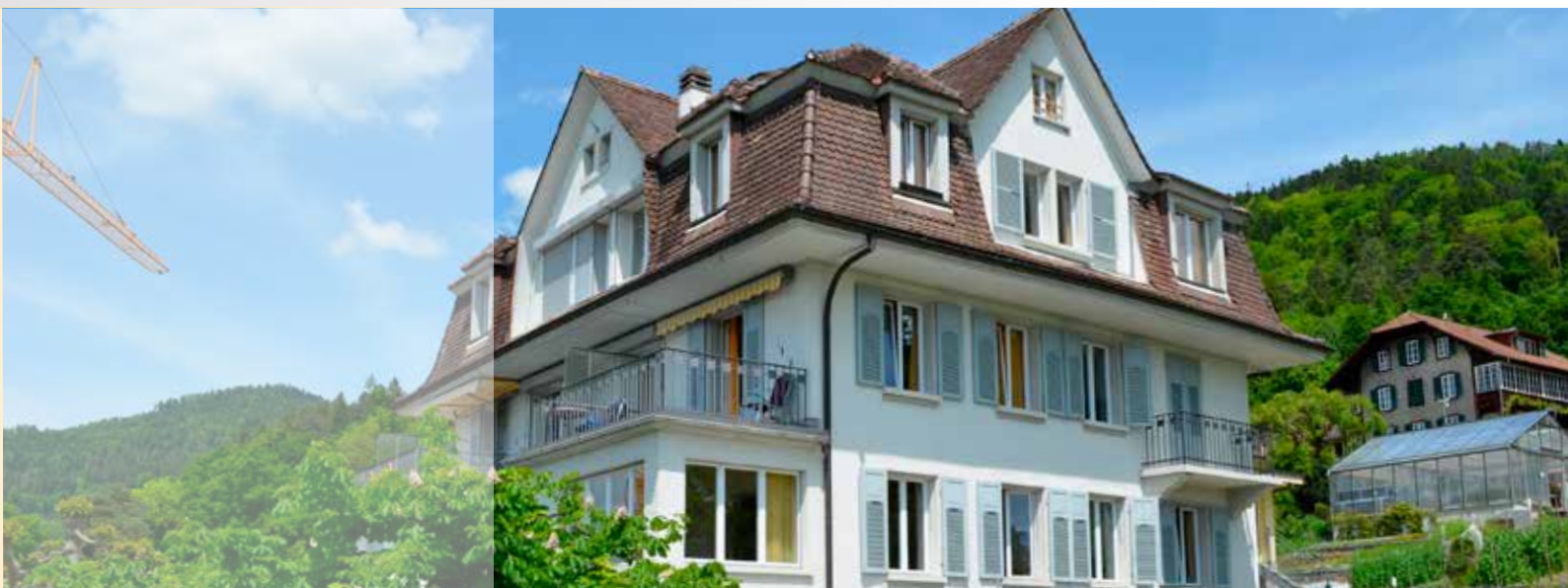
Vor der Dachsanierung
